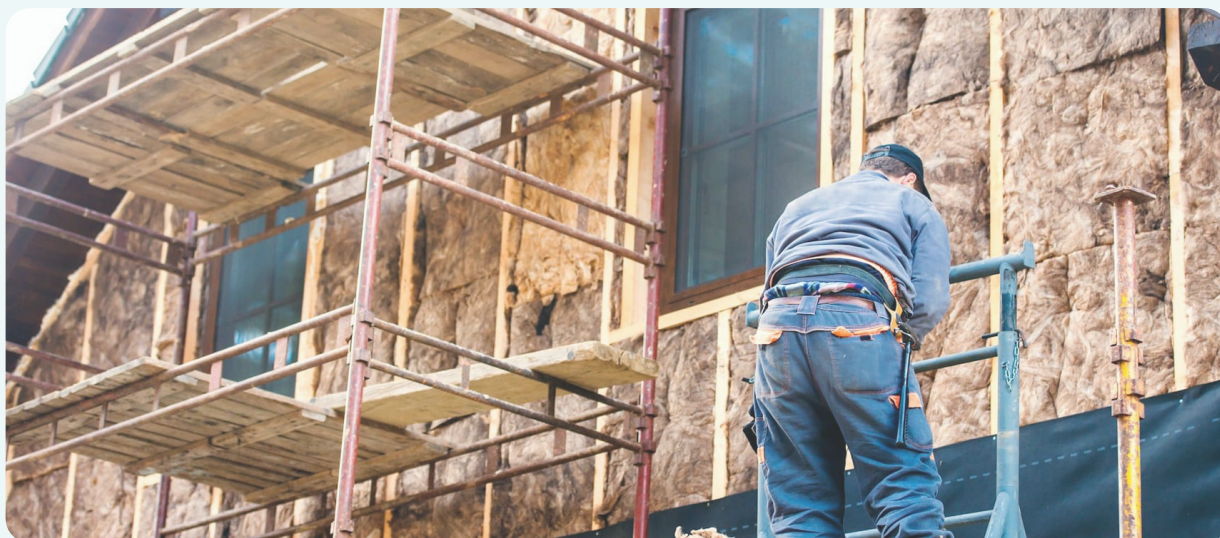
Isolation thermique par l'extérieur
