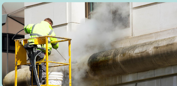
Nettoyage d'une façade à la vapeur
