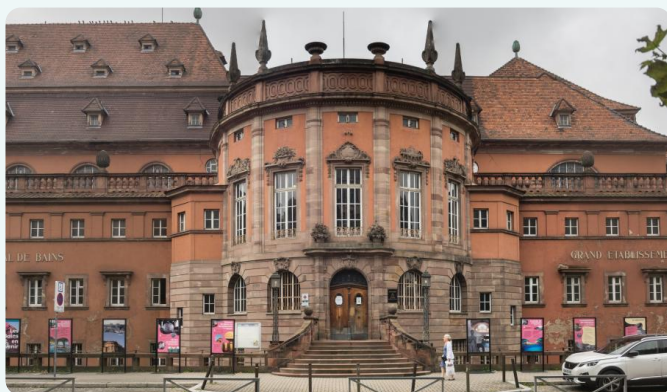
Les Bains Municipaux de Strasbourg, bâtiment situé sur une zone couverte par le PSMV, peint avec de la peinture minérale
