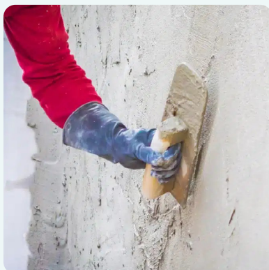
Enduit à la chaux
