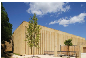
Façades en pierre massive brute Gilles Perraudin - Chai viticole Solon - France - 2008
